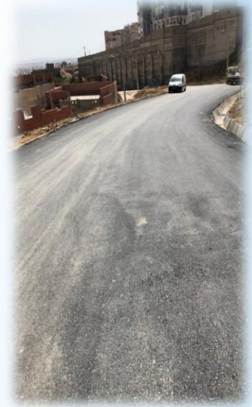
تهيئة طريق برج التركي
