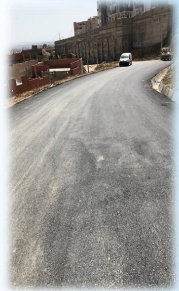
تهيئة طريق برج التركي
